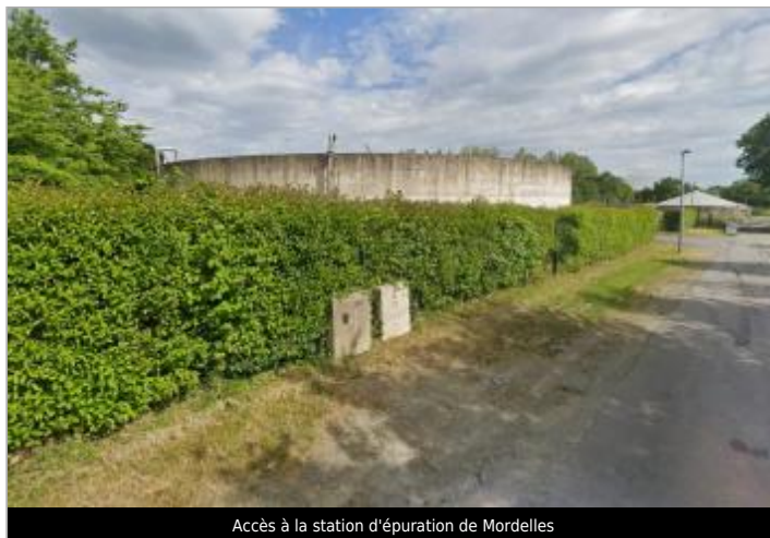
Accès à la station d'épuration de Mordelles
