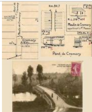
profil en long de l'Ognon et photo de l'ancien pont
