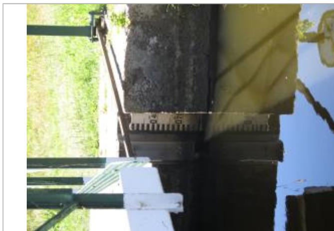
Echelle limnimétrique amont de l'écluse de Manevern à Languidic
