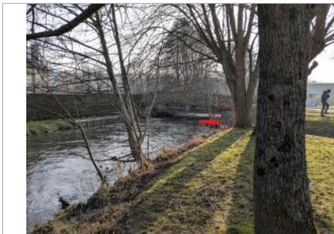
Vue depuis la berge amont, rive droite.
