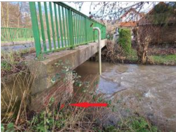
Laisse de crue à 1.52 m du haut du tablier du pont (Photo SYMA).
