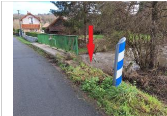
Vue depuis la rue de l'Andelle
