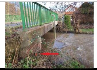
Laisse de crue à 1.52 m du haut du tablier du pont (Photo SYMA)
