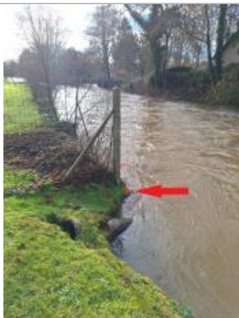
Laisse de crue au pied du poteau (Photo SYMA).
