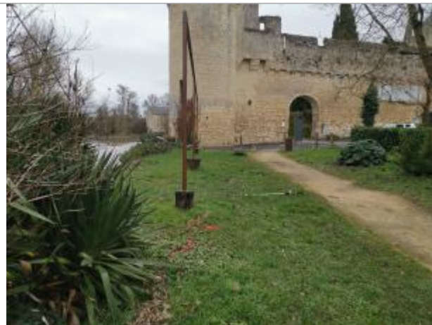
Vue du site - auteur : AGERIN
