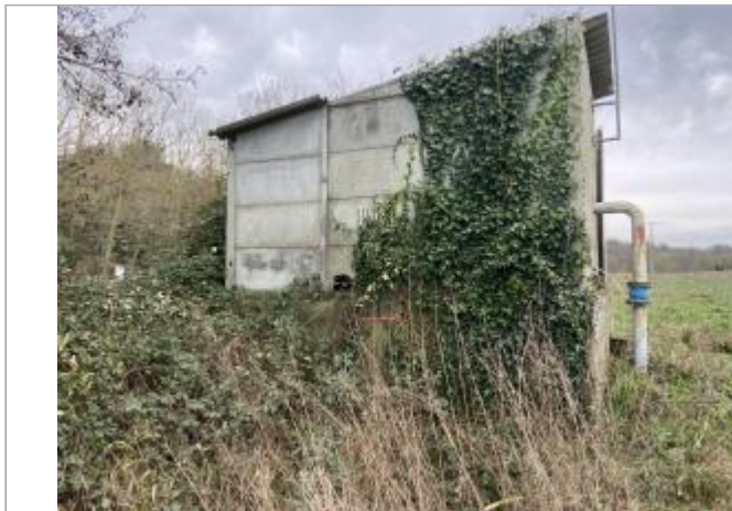
Vue du site - auteur : AGERIN
