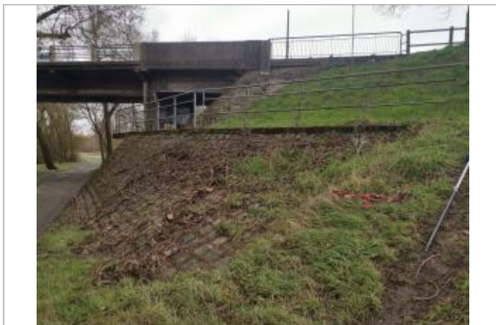
Vue du site - auteur : AGERIN
