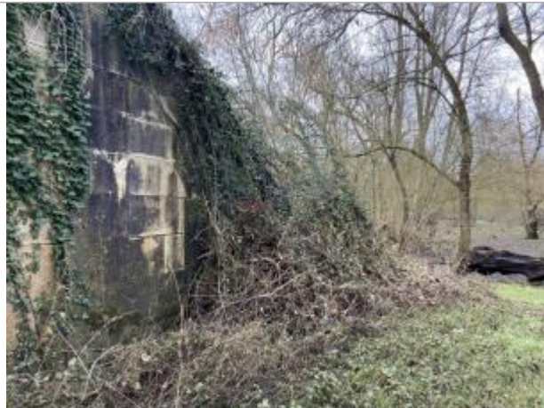
Vue du site - auteur : AGERIN
