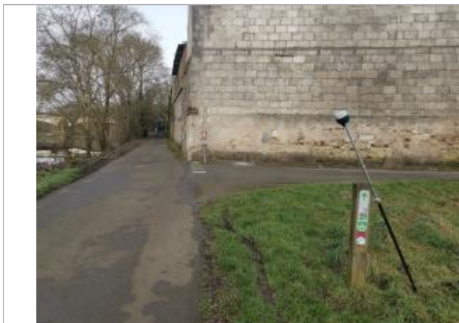
Vue du site - auteur : AGERIN
