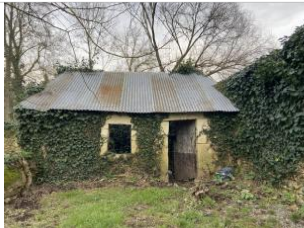
Vue du site - auteur : AGERIN
