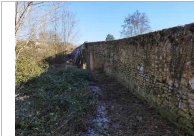
Vue du site - auteur : AGERIN
