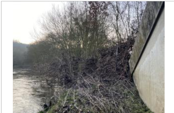
Vue du site - auteur : AGERIN
