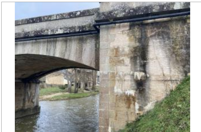
Vue du site - auteur : AGERIN
