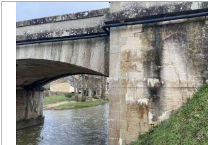
Vue du site - auteur : AGERIN
