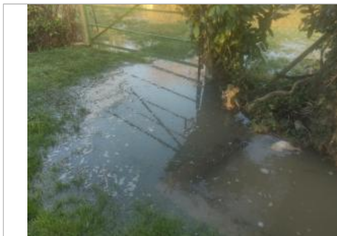
Vue éloignée_buse béton (source SMBVR)
