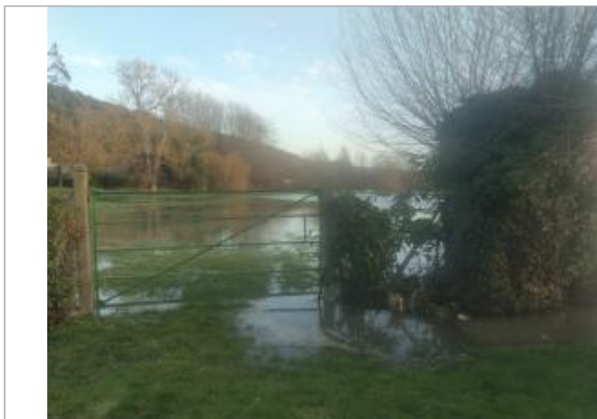
Vue d'ensemble_buse béton_rue du pont joly (source SMBVR)
