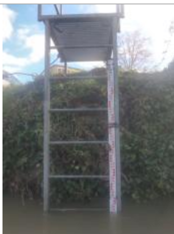
Vue d'ensemble de l'échelle (source SMBVR)
