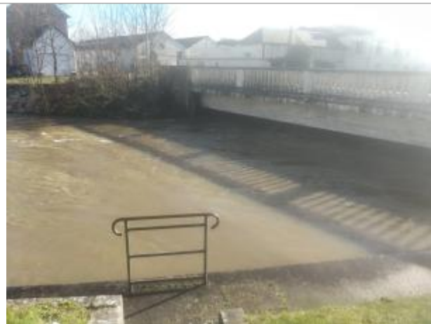
Vue d'ensemble du site plateforme béton et le pont (source SMBVR)
