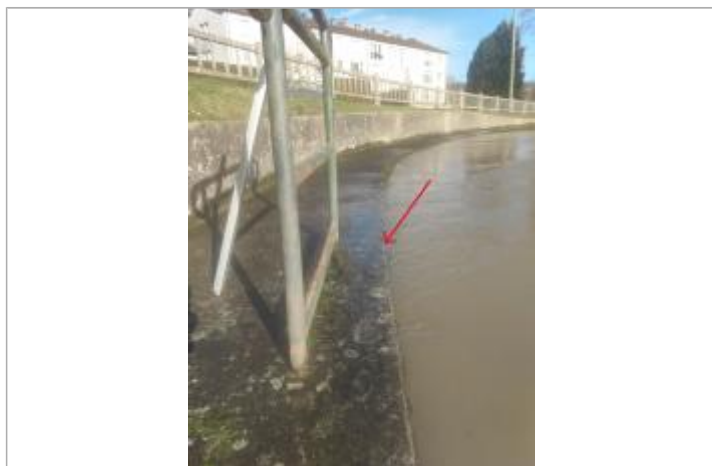
Niveau d'eau égal plateforme béton en contrebas des marches (source SMBVR)
