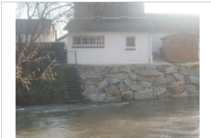
vue_générale_escalier_Bien_20boulevardEugeneMarie (source SMBVR)
