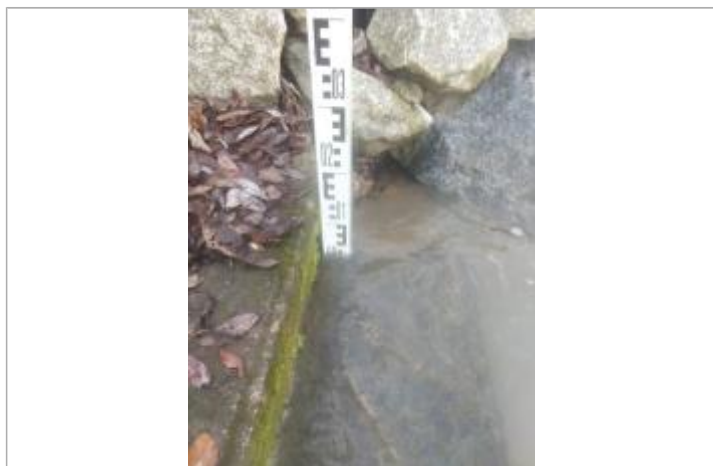
4ième marche - hauteur d'eau 2cm (source SMBVR)
