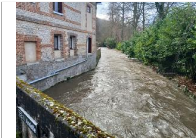
vue depuis le pont du chemin du Pouchet.
