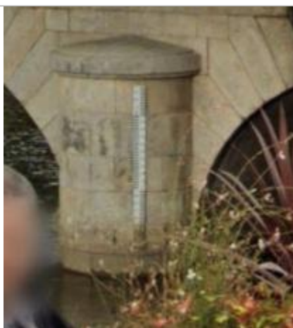
Echelle limnimétrique sur pile aval pont du quartier
