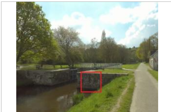
Aval de l'écluse de la Cascade à Pontivy
