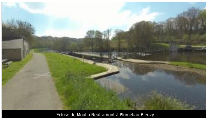
Ecluse de Moulin Neuf amont à Pluméliau-Bieuzy
