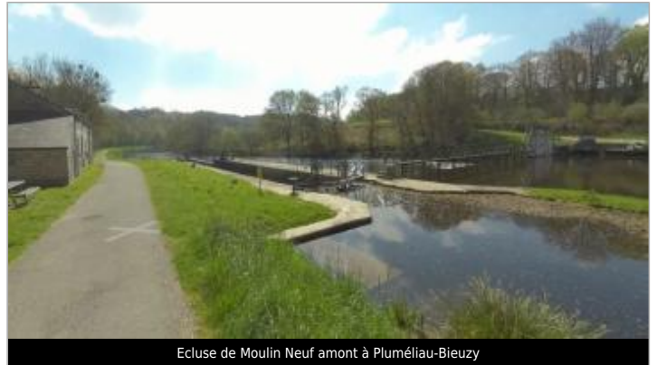
Ecluse de Moulin Neuf amont à Pluméliau-Bieuzy
