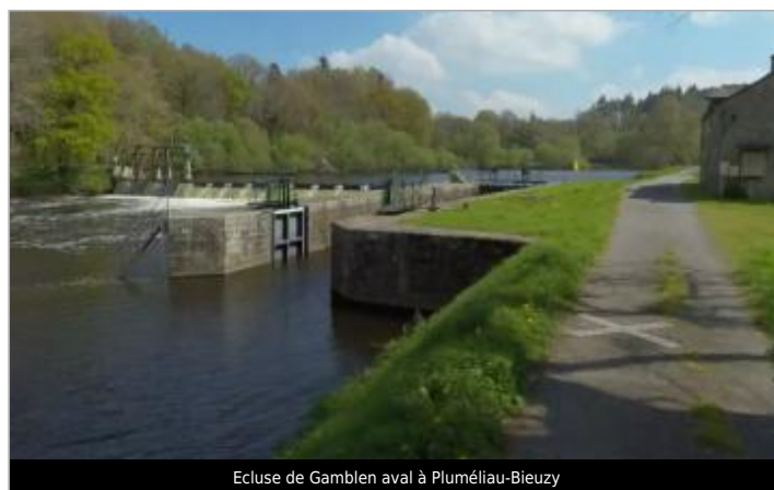
Ecluse de Gamblen aval à Plumélieu-Bieuzy
