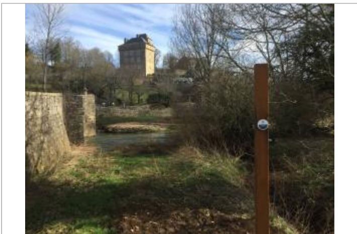
Repère de crue du 4 décembre 2003 de Montrozier
