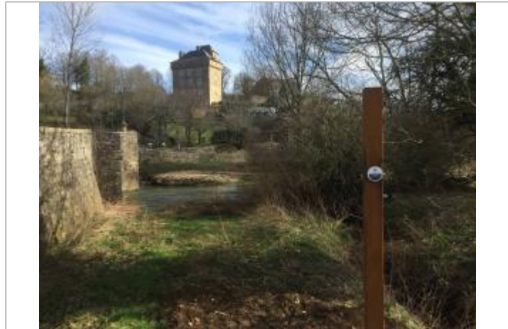
Repère de crue du 4 décembre 2003 de Montrozier
