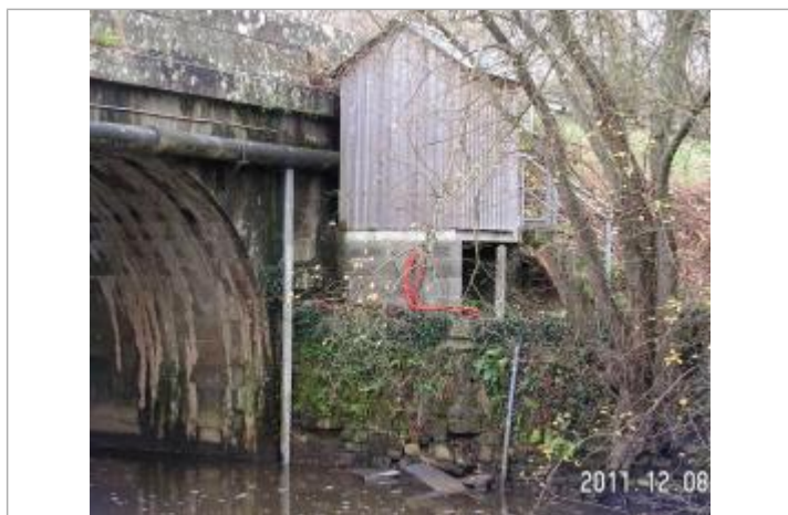
Echelle limnimétrique du Couesnon à Romazy
