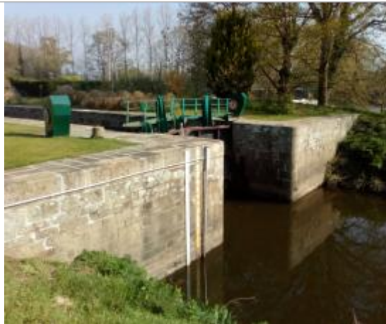
Aval de l'écluse du Guélin
