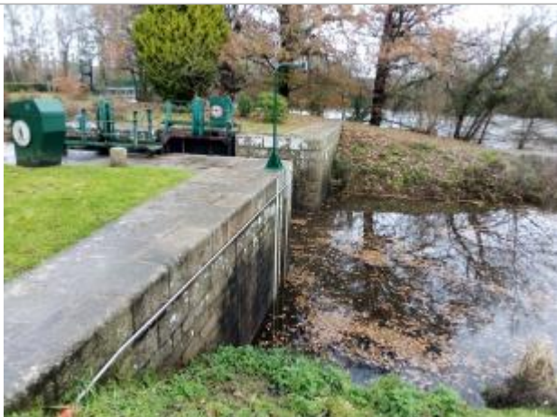
Echelle et radar à l'aval de l'écluse du Guélin
