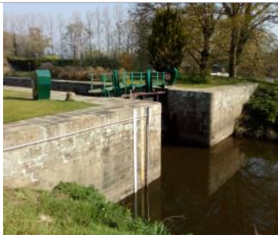
Aval de l'écluse du Guélin
