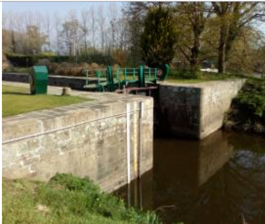
Aval de l'écluse du Guélin
