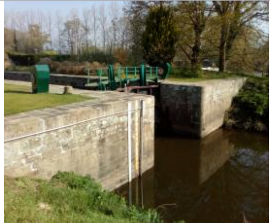
Aval de l'écluse du Guélin
