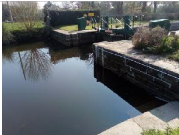
Amont de l'écluse du Guélin
