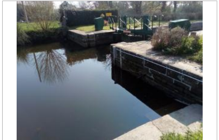
Amont de l'écluse du Guélin
