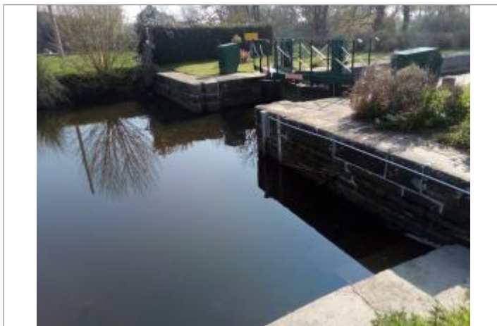
Amont de l'écluse du Guélin
