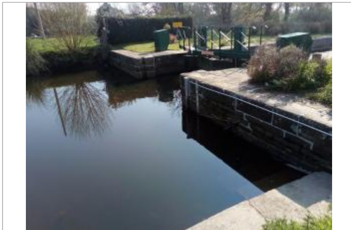
Amont de l'écluse du Guélin
