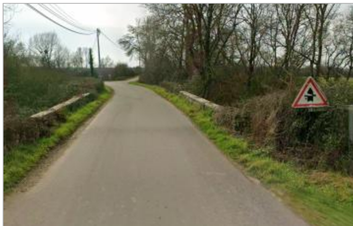
Station d'hydrométrie de l'Isac à Saffré
