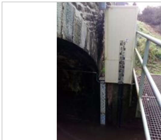
Echelle limnimétrique du Canut sud à Saint-Just
