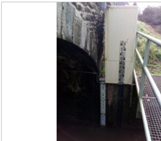
Echelle limnimétrique du Canut sud à Saint-Just
