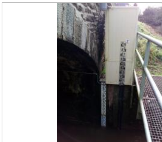
Echelle limnimétrique du Canut sud à Saint-Just
