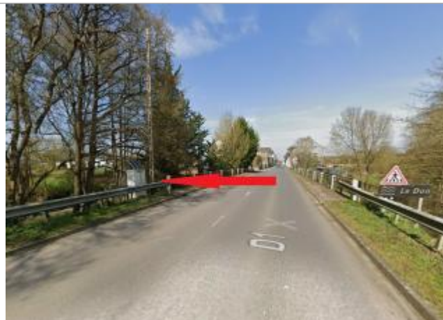
Station d'hydrométrie du Don à Tréffieux sur la RD 1
