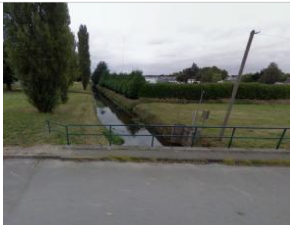
Station hydrométrique de la Chère à Chateaubriant
