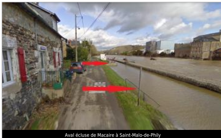
Aval écluse de Macaire à Saint-Malo-de-Phily
