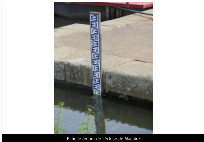
Echelle amont de l'écluse de Macaire
