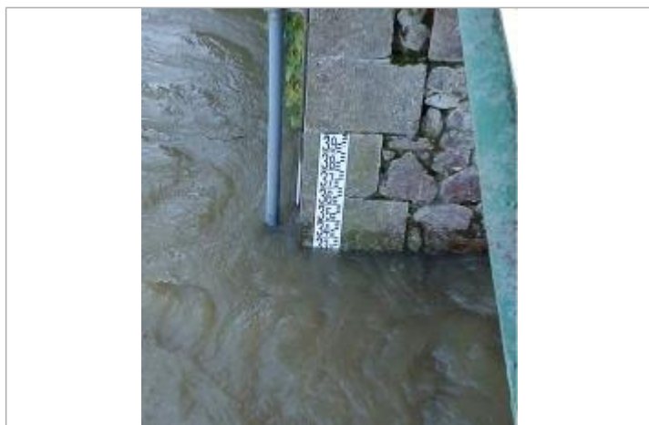
Echelle limnimétrique du Semnon à Bain de Bretagne
