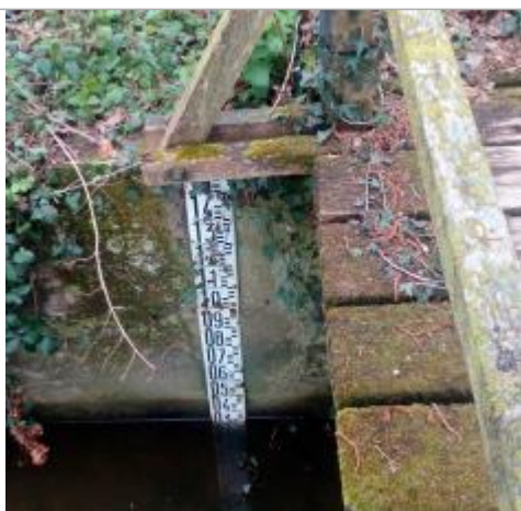
Echelle limnimétrique de la station du Canut nord à Maxent
