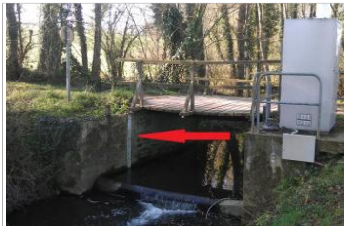
Station limnimétrique du Canut nord à Maxent
