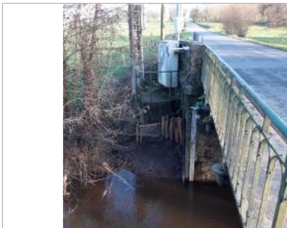
Station Vigicrues de la Flume à Pacé
