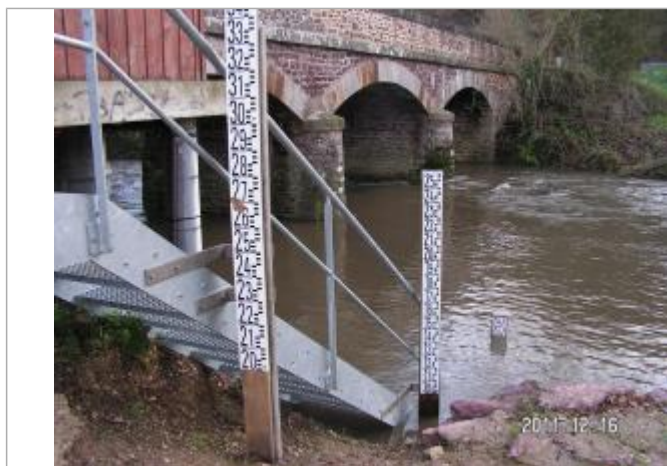
Echelles limnimétriques de la station Vigicrues du Meu à Montfort
