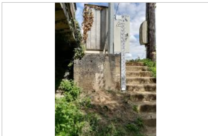
Echelle limnimétrique de la station Vigicrues à Amanlis
