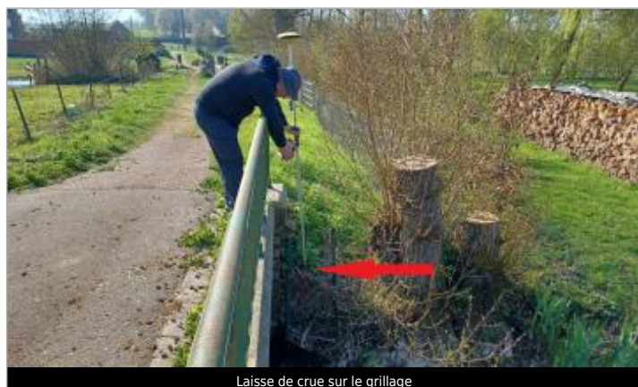
Laisse de crue sur le grillage
