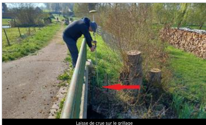
Laisse de crue sur le grillage
