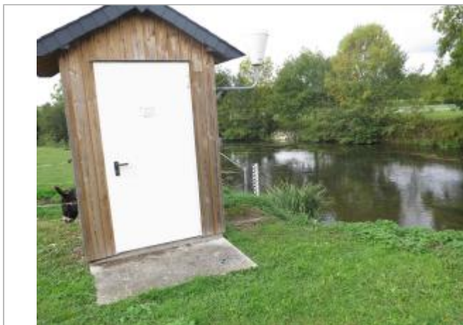
Vue générale de la station de Pont Briand à Cesson Sevigné
