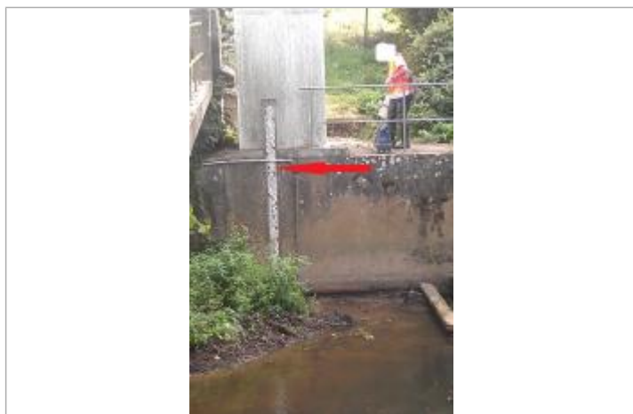
Echelle limnimétrique du Chevré (Veuvre) - Le Drujeon
