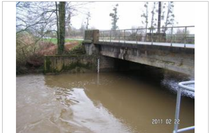
Station limnimétrique du Chevré (Veuvre) - Le Drujeon
