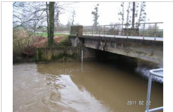
Station limnimétrique du Chevré (Veuvre) - Le Drujeon
